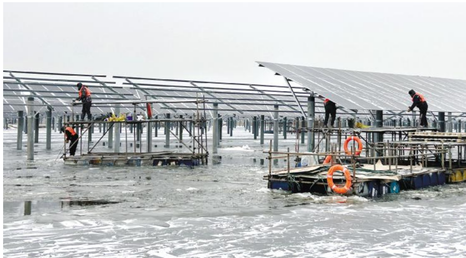
通威丰南“渔光一体”二期项目建设现场
