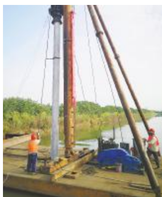
2021年10月2日,通威天门二期100MW“渔光一体”项目开工
