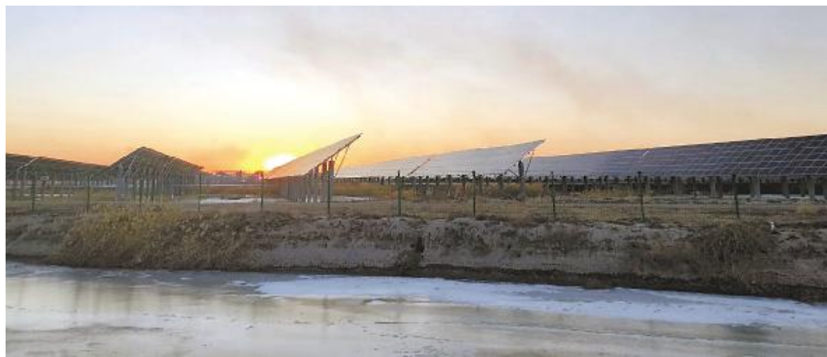
通威肇源“渔光一体”基地
