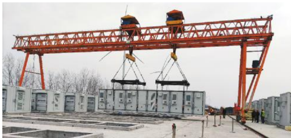
天门项目升压站抓紧建设
