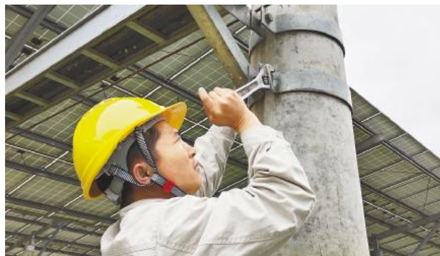
紧固螺栓,保障电站资产安全
