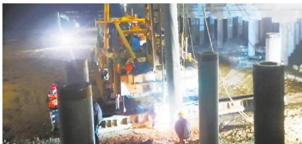
挑灯夜战施工忙,跑出建设“加速度”
