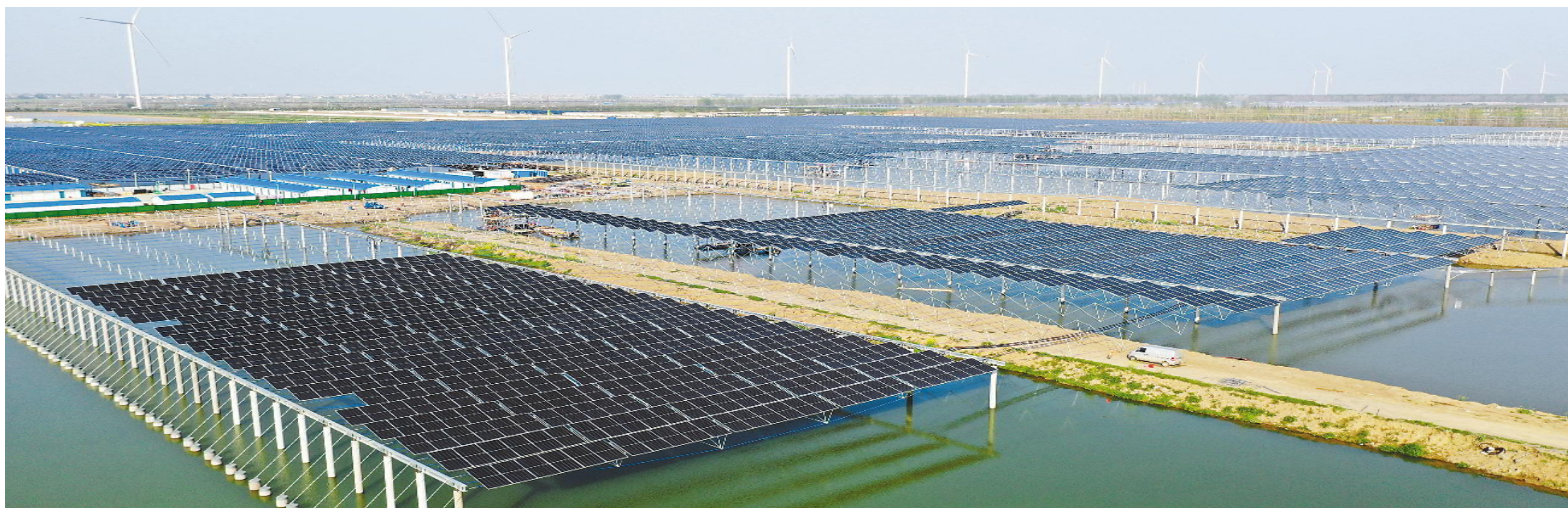
天门二期项目建设稳步推进
