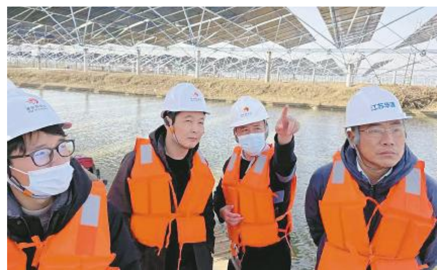
通威新能源常务副总经理吴小平定期跟进项目建设进度
