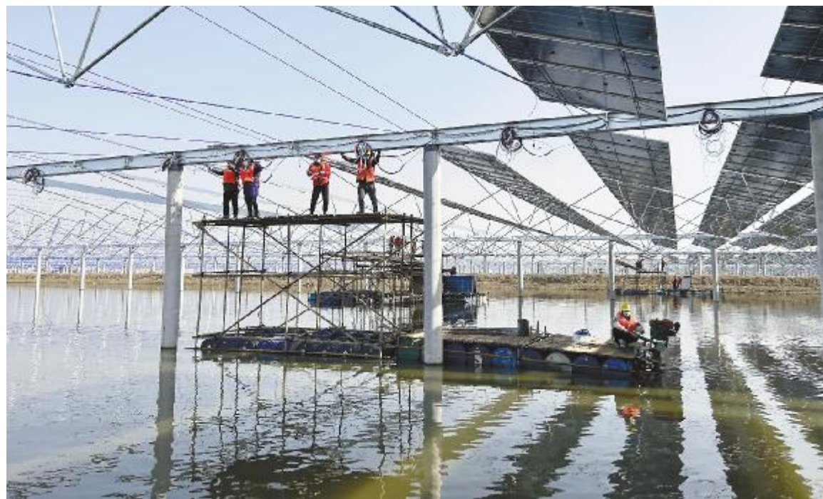
安装光伏板,抢抓施工进度
