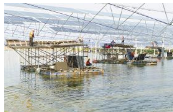
天门二期项目建设现场
