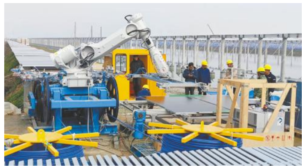
组件自动化安装设备野外测试
