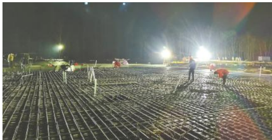
夜以继日,抢抓施工
