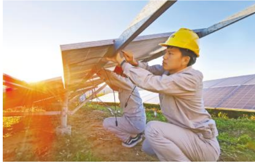
专注的运维人,更换光伏组件
