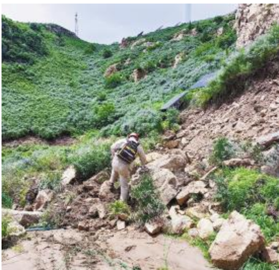
凌海电站运维人员踏着泥泞,排查光伏区设备
