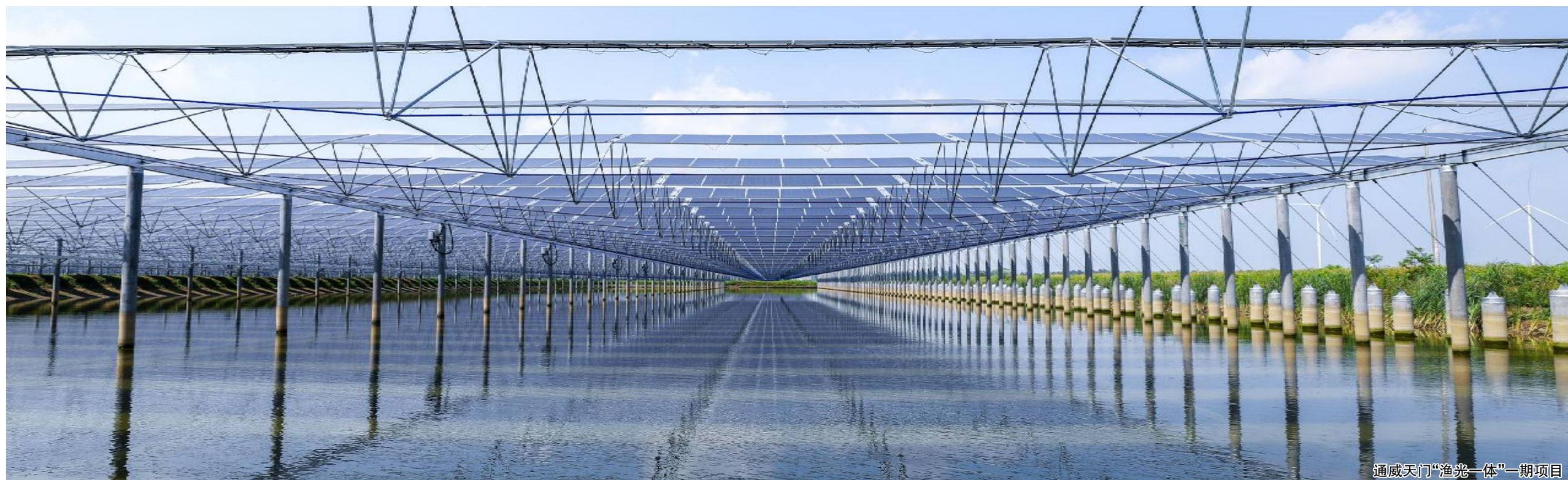
通威天门“渔光一体”一期项目
