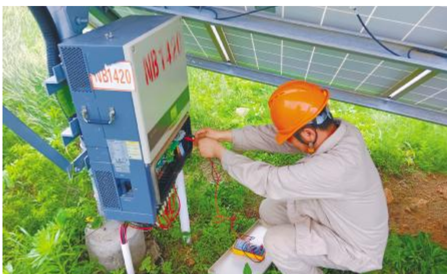
凌海电站运维人员排查设备故障
