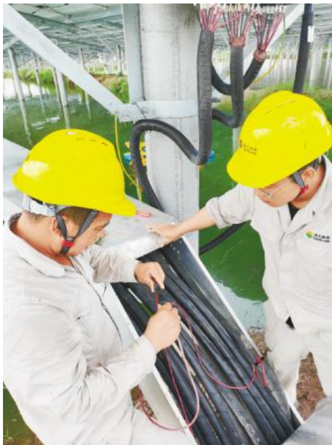
通威钦州“渔光一体”基地开展消缺培训
