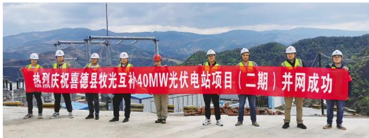
通威喜德牧光互补光伏电站二期项目成功并网
