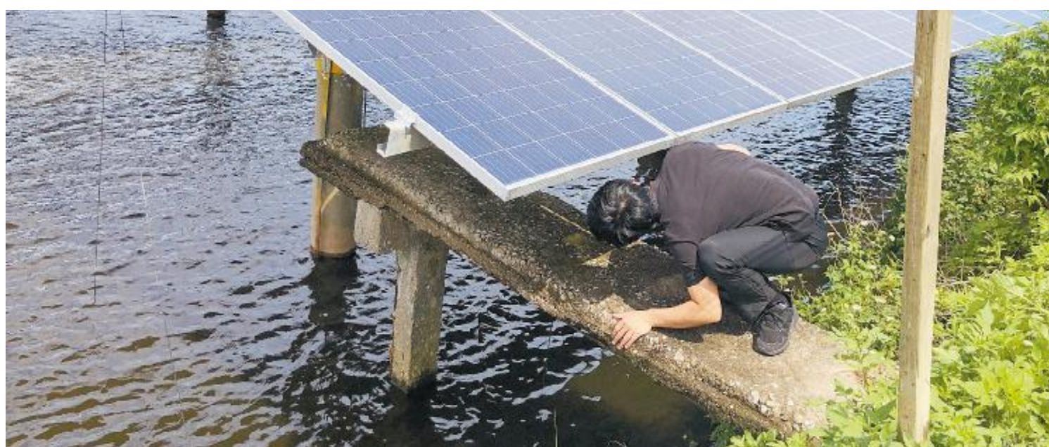
标准编制组实地调研光伏电站
