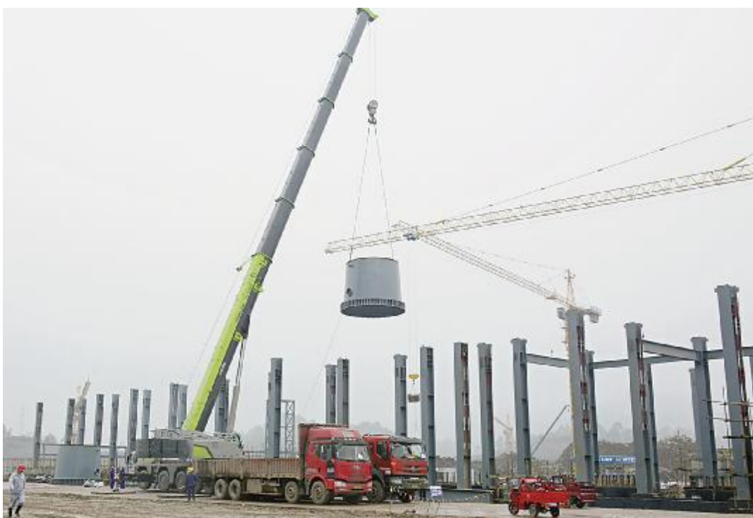
永祥新能源二期项目精馏塔裙座成功起吊
