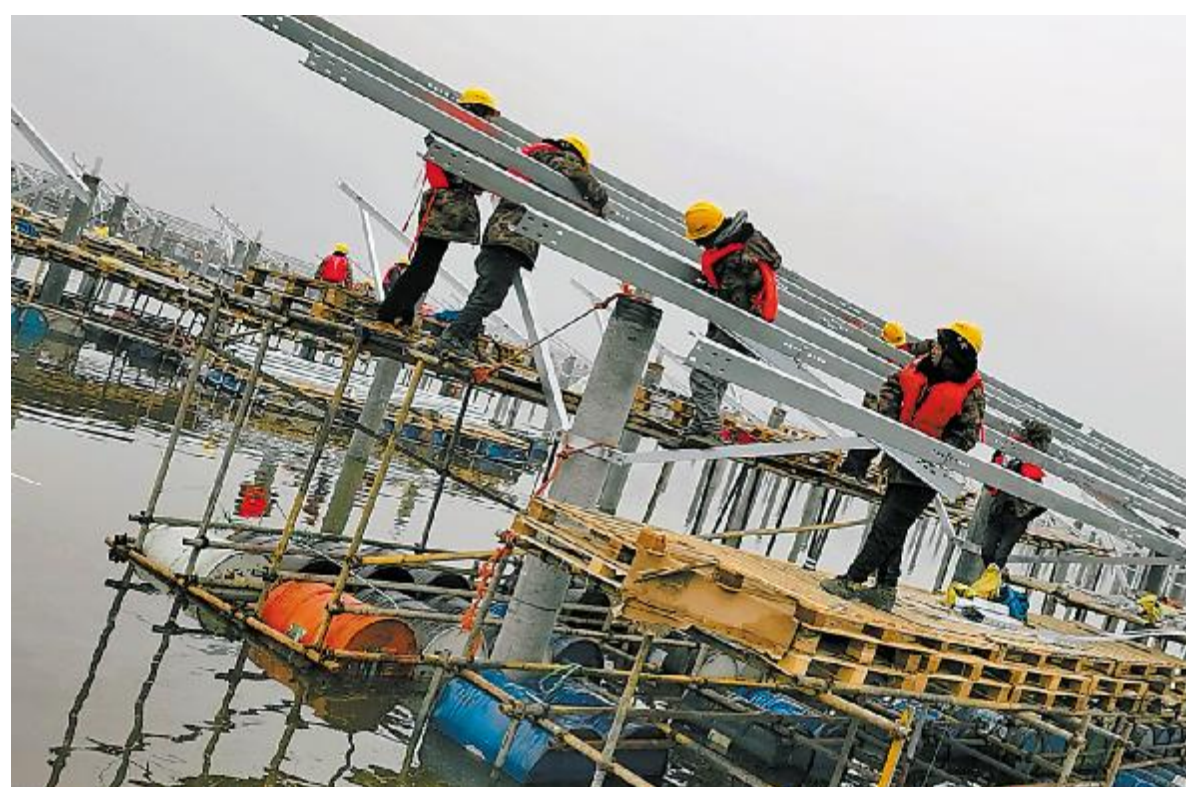
通威蚌埠“渔光一体”项目施工忙
