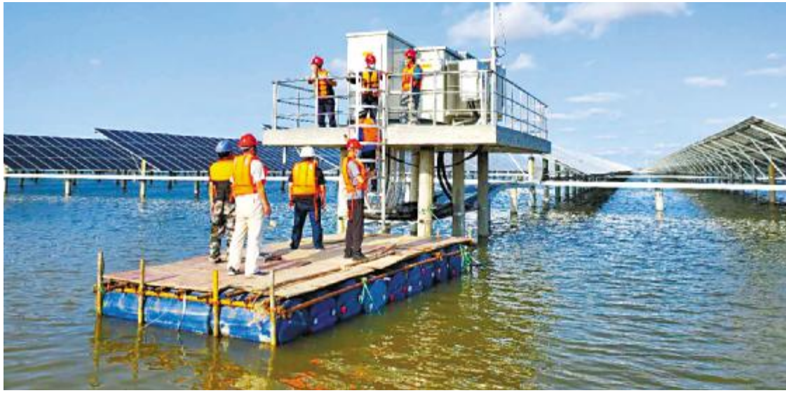
滨州沾化项目施工现场
