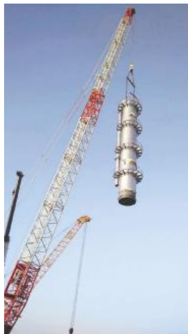
永祥股份包头高纯晶硅项目精馏塔空中组对现场
