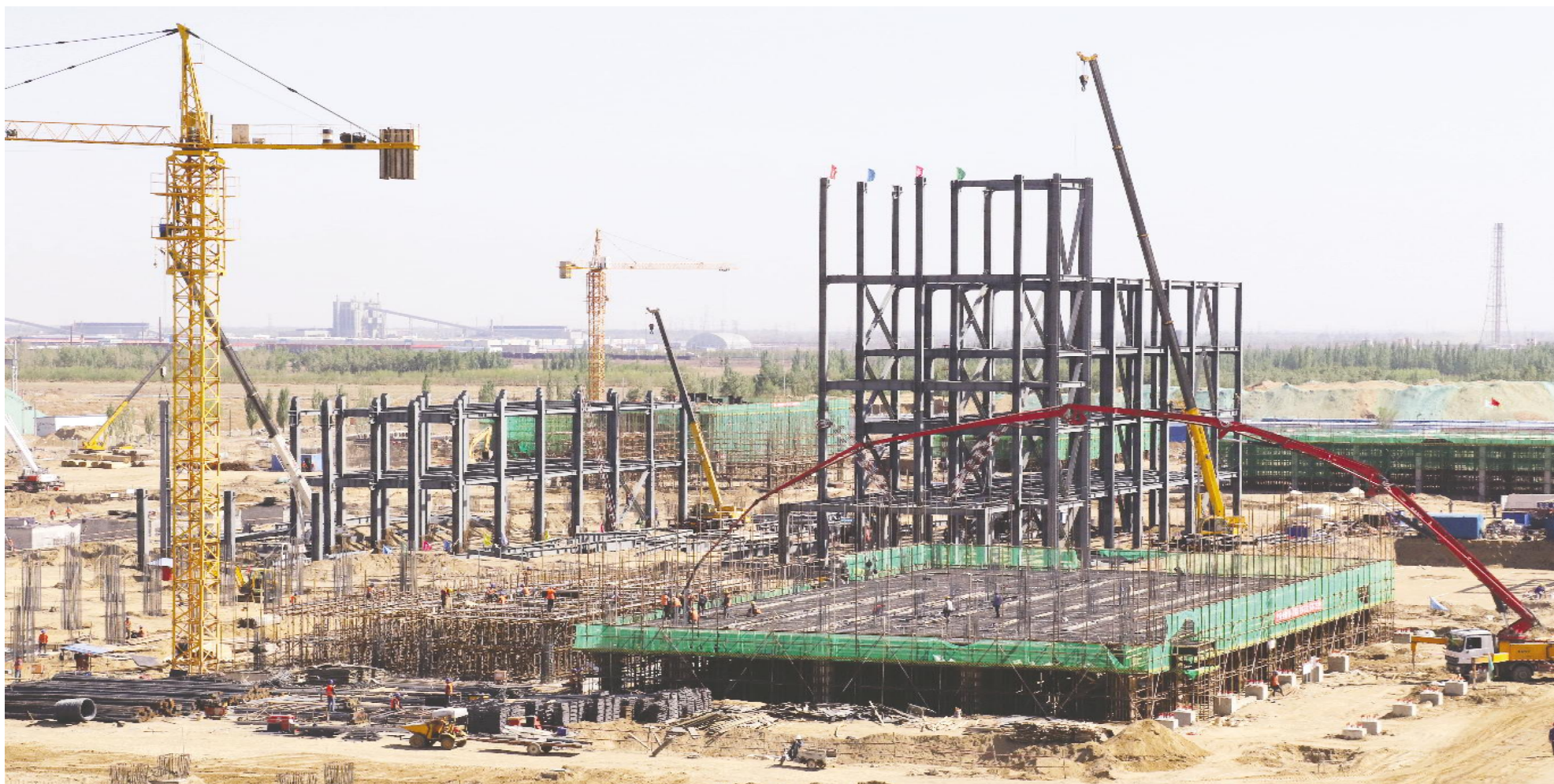
永祥股份包头高纯晶硅项目建设现场
