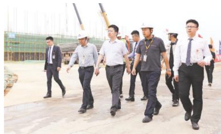
谢毅董事长在办公楼建设区域现场查看工程进度
